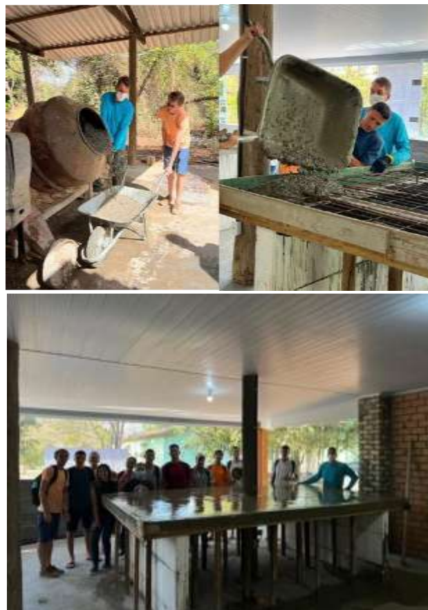
Figura 1 – Acadêmicos e Professores em execução de obra
